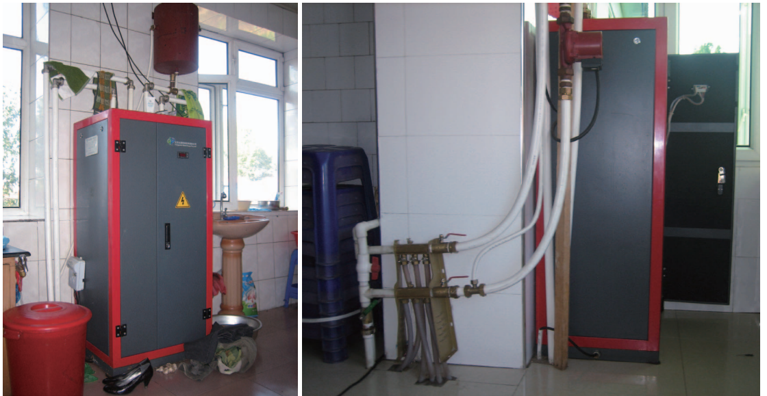
图 4-9 农户家中的热泵机组
