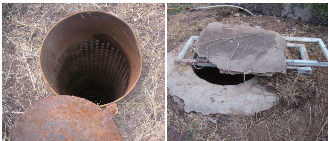
图 4-8 农户后院浅层地能利用的提水井和回灌井
