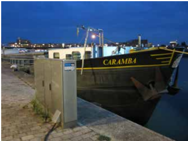
图4：鹿特丹的岸电连接柜(左) 及其上关于如何连接岸电和停止岸电供应的说明(右)
