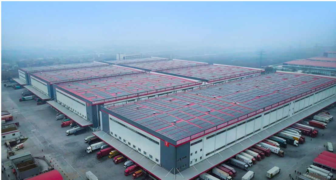
图 3-5：碳中和物流园区 13 （2021 年京东“亚洲一号”西安智能产业园通过节能改造 + 光伏 + 储能 + 核证减排量，获得北京绿色交易所和华测认证（CTI）颁发的碳中和证书，成为中国首个获评的碳中和物流园区。）
