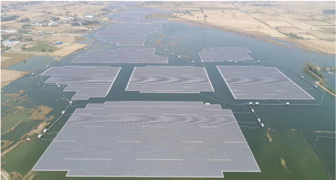
图 3-7：中国节能安徽宿州淮北矿区采煤沉陷区水上光伏项目
