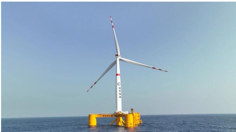
图 5-1 深远海浮式风电平台
